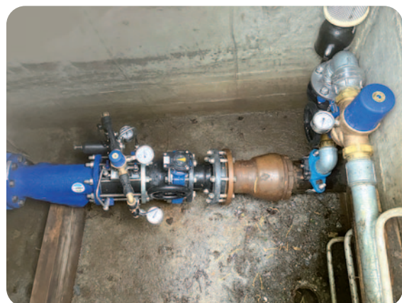
Rohrbruchklappen neu
