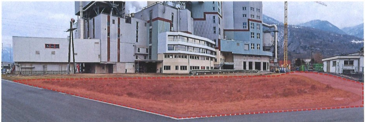
Abbildung 3: Panoramabild des Bereichs für den Zentralenstandort (Baurechtsfläche rot eingefärbt).
